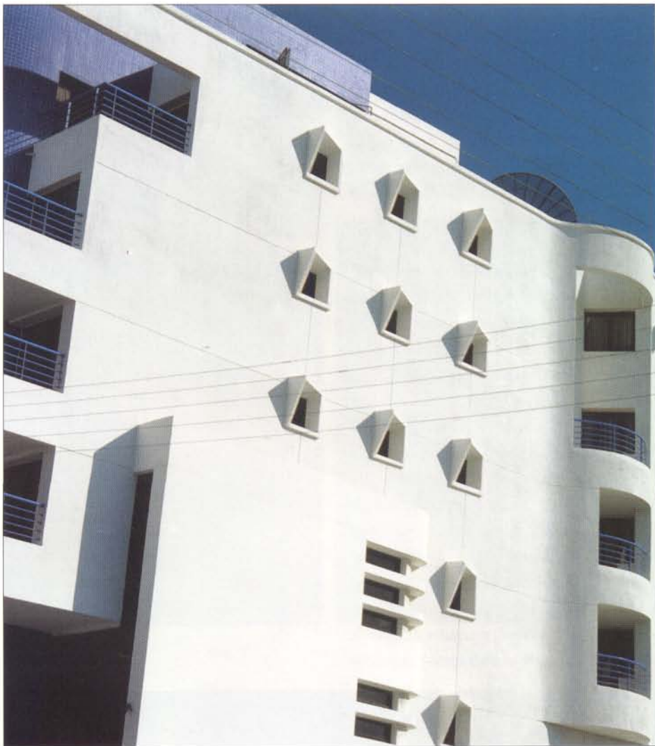
Une façade animée par des ouvertures et des décrochements variés avec notamment de singuliers brise-soleil à la fois visières et encadrements de fenêtre.
